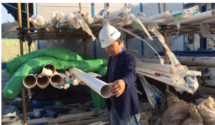
图 现场抽检排水管材
